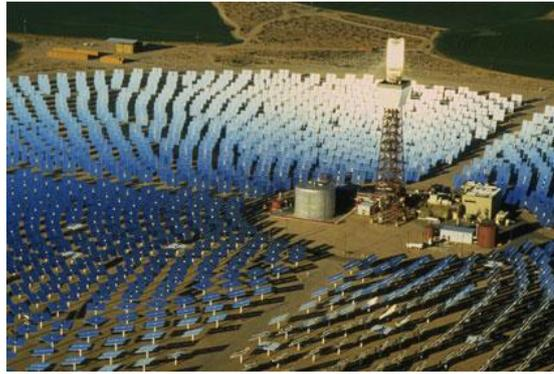
*Paneles de energía solar. En la parte central, se observa el colector de energía, hacia el que se dirigen todos los paneles.*
